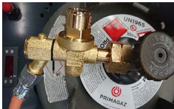
Afb. 3-4: Tilslutning af gasslangen
