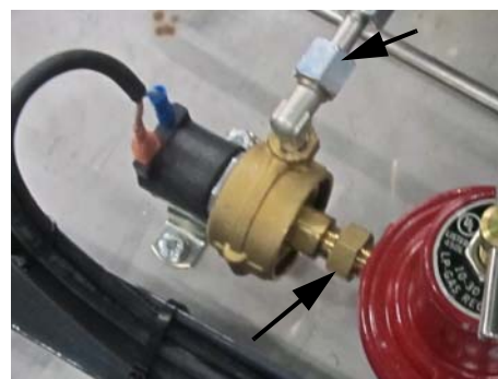
Fig. 9-3: Udskiftning af gasfilter (1)
