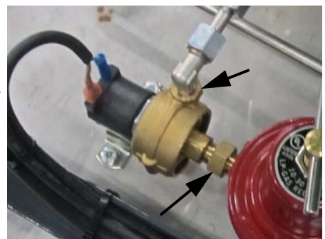
Fig. 9-9: Udskiftning af gasfilter (7)
